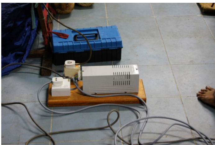
Foto 5 Transformer yang digunakan untuk meningkatkan kuasa
