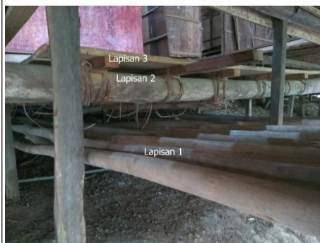
Foto 4 Tiga lapisan pentas lansaran . Lapisan 1: Bahagian bawah (batang kayu) Lapisan 2: Bahagian tengah (batang kayu) Lapisan 3: Bahagian atas (papan) Sumber: Koleksi pengkaji, Muzium Negeri Sabah (21 April 2017).
