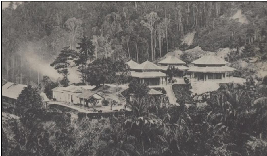
Rajah 1: Hospital Kerajaan Sandakan
