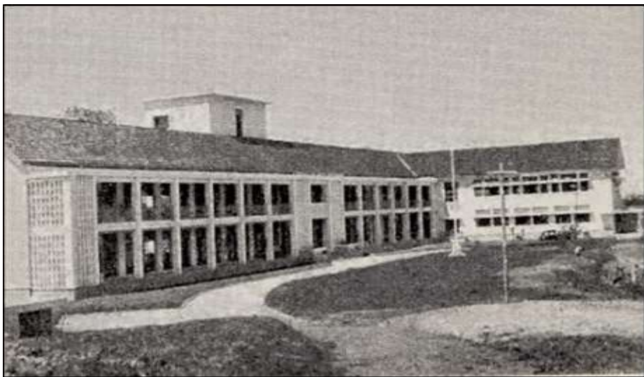
Foto 1 : Bangunan Hospital Duchess of Kent yang telah disiapkan
