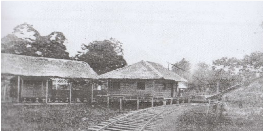
Foto 2 Stesen Kereta Api Bukau
